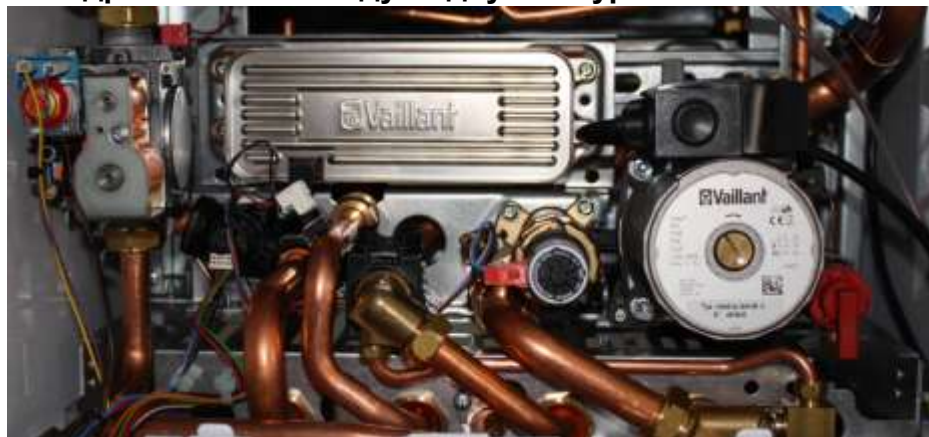
Гидравлический модуль двухконтурного котла VUW
