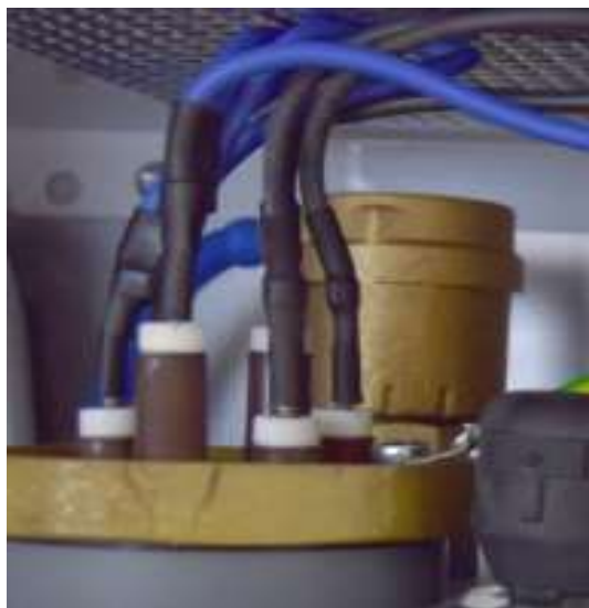
Автоматический развоздушивающий клапан
