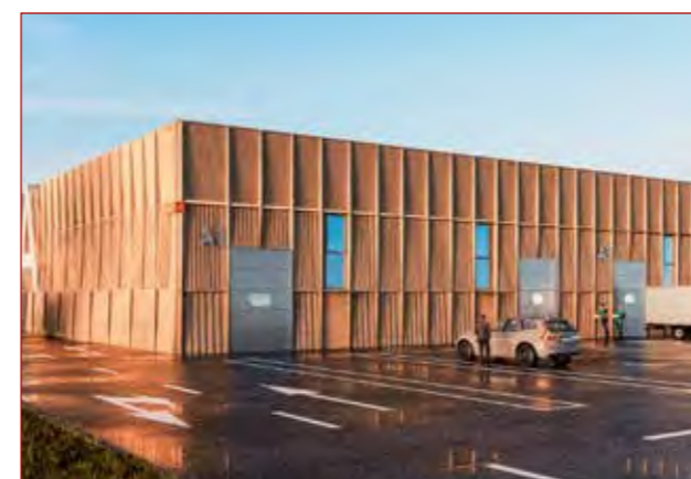
Меблева фабрика та магазин Віяр, Одеса, вентиляційні установки AHE-300WB1 (4 шт.)
